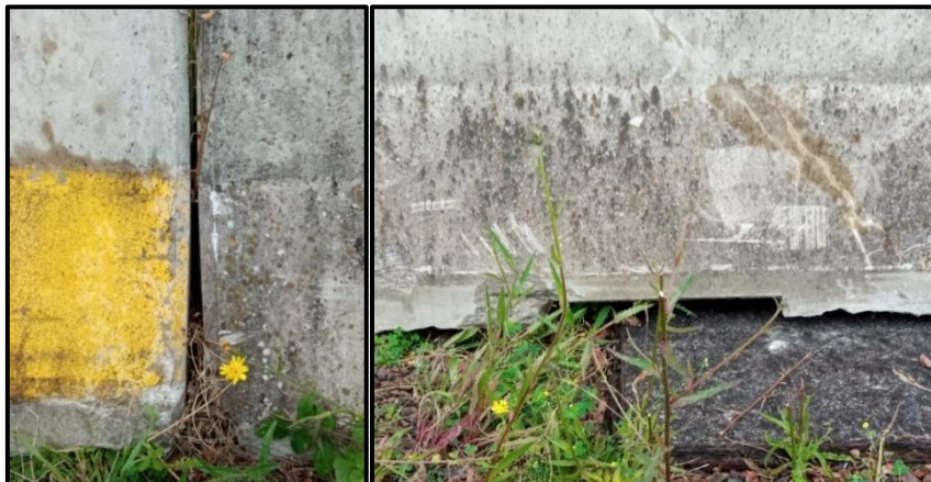
Photo 6 : Interstices observés sur la barrière amphibien
