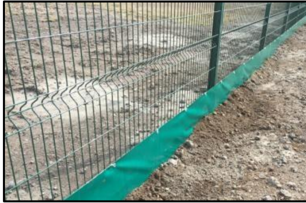
Photo 3 : Exemple de barrière amphibien
