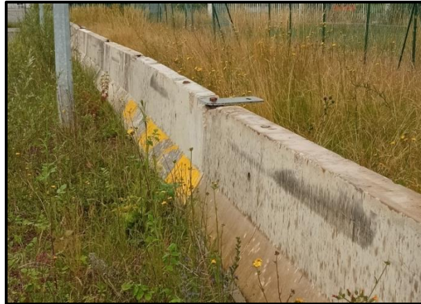
Photo 5 : Prototype de barrière amphibien en bordure de la prairie au Sud-ouest de la zone d'étude (Rainette, 2021)
