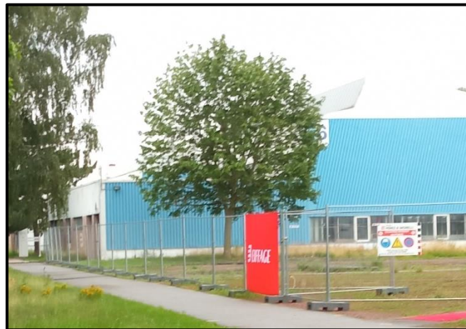
Photo 1 : Mise en place de clôtures en bordure du chantier (Rainette, 2021)
